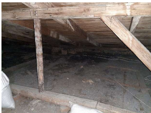
4.8.1.3. att. Jumta nesošās konstrukcijas
