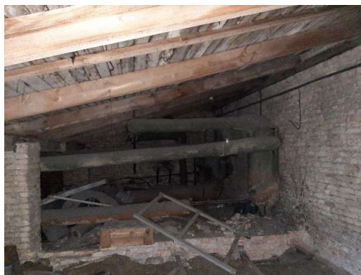
4.6.2.4. att. Pirmā stāva koka pārsegums, uz pārseguma tiek uzglabātas neekspluatējamas inženiersistēmas
