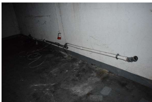
5.2.1.3. att. Sanitāro iekārtu kanalizācijas pievadi
