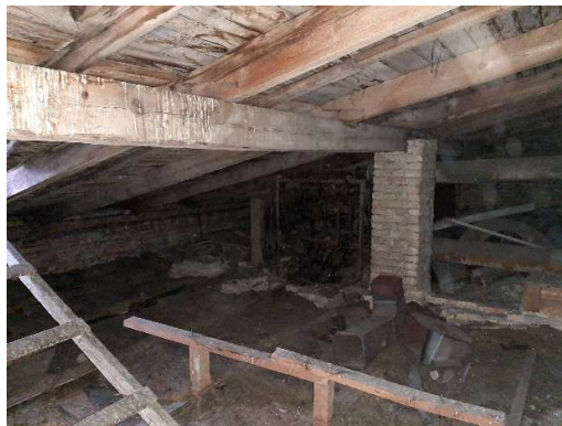
4.8.1.2. att. Jumta nesošās konstrukcijas
