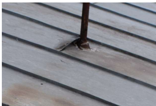
4.8.2.6. att. Nehermētisks jumta seguma un inženiertīklu izvada savienojums
