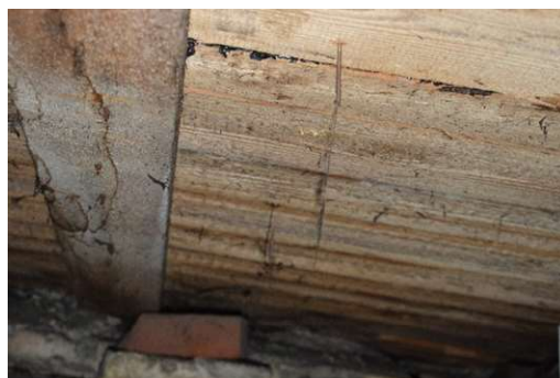
4.8.1.6. att. Jumta nesošās konstrukcijas
