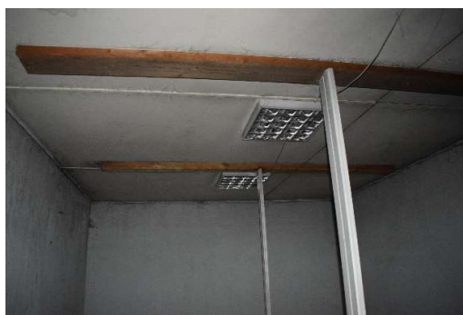
4.6.2.6. att. Pirmā stāva koka pārsegums, uzstādītie pagaidu balsti
