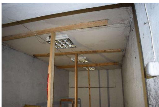
4.6.2.5. att. Pirmā stāva koka pārsegums, uzstādītie pagaidu balsti
