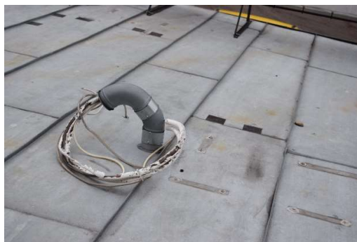
4.8.2.8. att. Nedemontēti dzesēšanas sistēmas ārējo bloku pievadi
