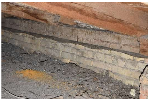
4.8.1.5. att. Jumta nesošās konstrukcijas
