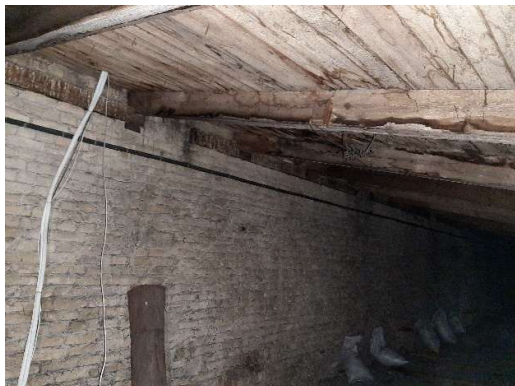
4.8.1.1. att. Jumta nesošās konstrukcijas
