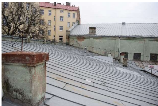
4.8.2.1. att. Jumta segums
