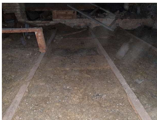
4.6.2.8. att. Pirmā stāva metāla siju pārsegums
