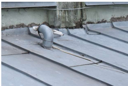
4.8.2.7. att. Nedemontēti dzesēšanas sistēmas ārējo bloku pievadi
