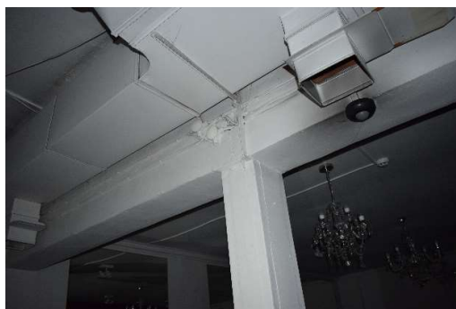
4.2.4.4. att. Pirmā stāva telpas Nr.9 kolonna un sijas
