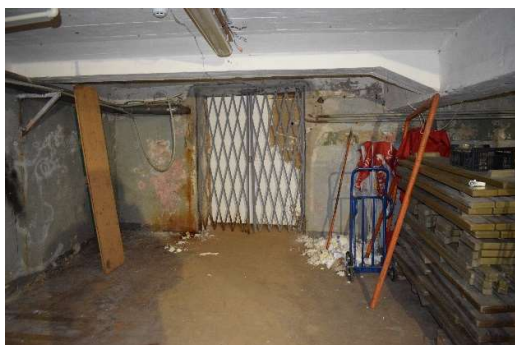
4.13.2.3. att. Durvis ēkas pagrabstāva ārsienā
