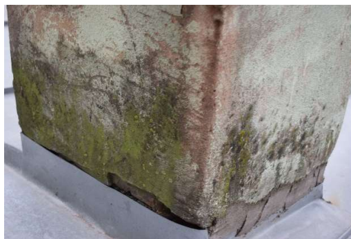
4.8.2.4. att. Nehermētisks jumta seguma un dūmeņa savienojums
