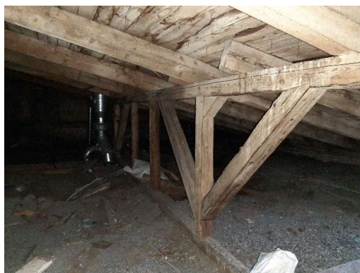
4.8.1.4. att. Jumta nesošās konstrukcijas
