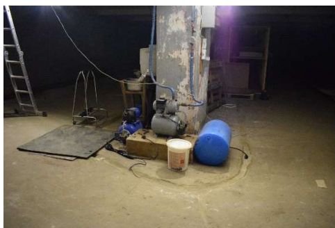
5.1.1.4. att. Aukstais ūdensvads, patēriņa skaitītājs ar spiediena paaugstināšanas iekārtu
