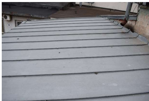
4.8.2.2. att. Jumta segums
