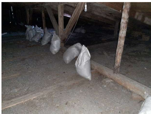
4.6.2.3. att. Pirmā stāva koka pārsegums, uz pārseguma tiek uzglabāti būvgruži
