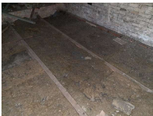
4.6.2.7. att. Pirmā stāva metāla siju pārsegums
