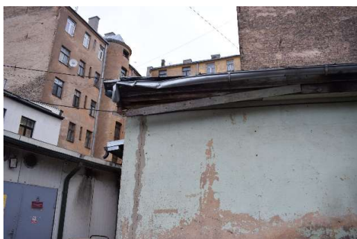
4.8.2.9. att. Bojāta lietus ūdens novadīšanas sistēmas tekne, iztrūkstošs stāvvads
