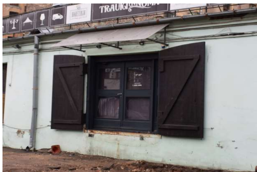
4.13.2.1. att. Ēkas ārdurvis rietumu fasādes pusē
