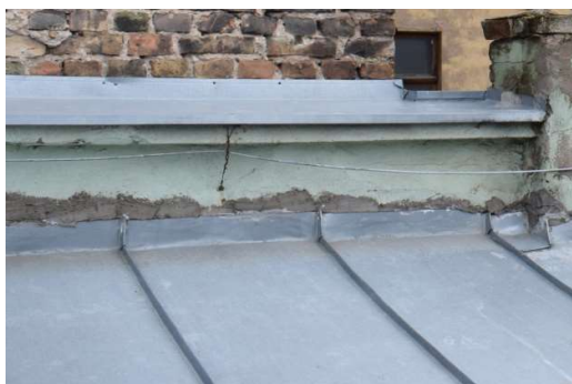
4.8.2.5. att. Nehermētisks jumta seguma un mūra savienojums
