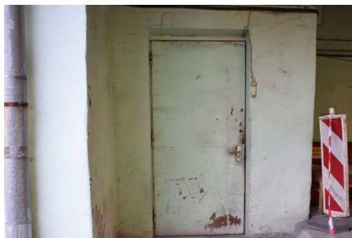
4.13.2.1. att. Ēkas ārdurvis dienvidrietumu fasādes pusē
