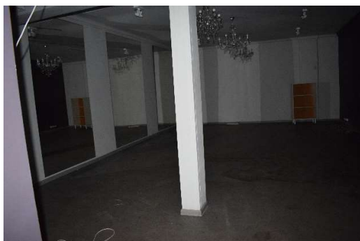
4.2.4.3. att. Pirmā stāva telpas Nr.9 kolonna un sijas
